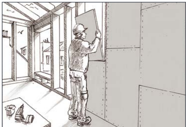
UNE PLAQUE DE FERMACELL FIXÉE À L'OSSATURE EN BOIS CÔTÉ INTÉRIEUR EST UTILISÉE COMME FOND DE COFFRAGE PERDU LORS DE LA PROJECTION DU CHANVRE. CE SYSTÈME PERMET DE PROJETER UNE COQUE CONTINUE DE CHAUX-CHANVRE DEPUIS L'EXTÉRIEUR ET D'ASSURER AINSI LA PERFORMANCE THERMIQUE DU BÂTIMENT.
