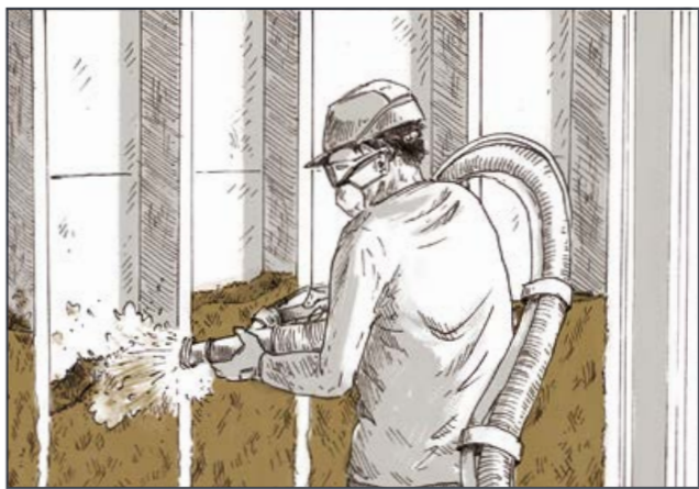
LE MÉLANGE CHAUX-CHANVRE EST PROJETÉ DEPUIS L'EXTÉRIEUR, EN VÉRIFIANT L'ÉPAISSEUR À L'AIDE D'UN NIVEAU LASER.
