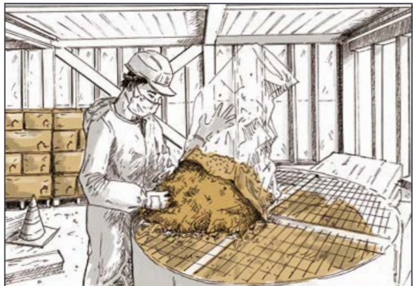
LE CHAUX-CHANVRE EST PRÉPARÉ SUR SITE. LA CHÈNEVOTTE ET LA CHAUX SONT MÉLANGÉES À SEC DANS LE MALAXEUR PLANÉTAIRE. L'EAU EST AJOUTÉE DIRECTEMENT DANS LA LANCE DE PROJECTION.
