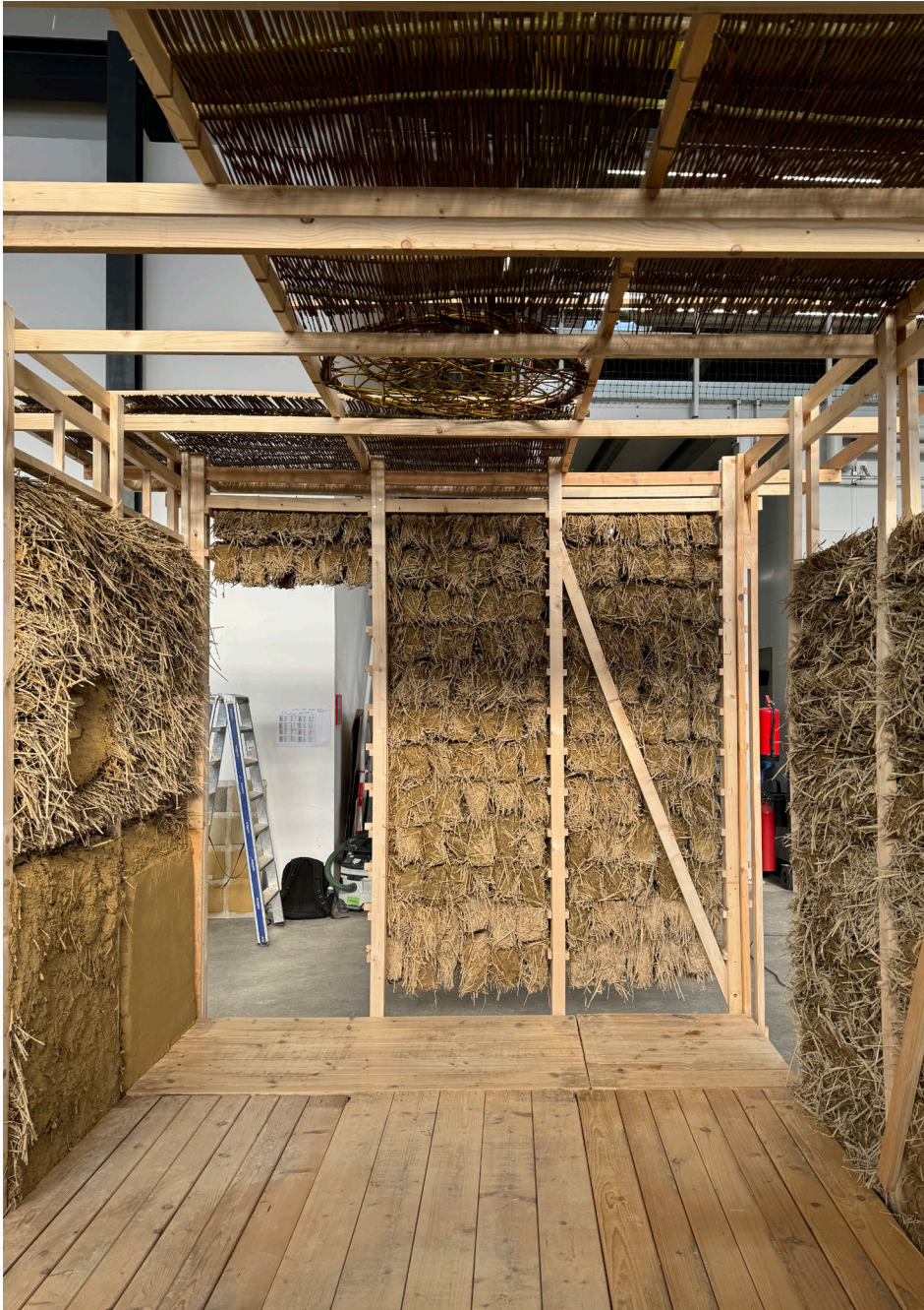
Processus de réalisation des boudins de torchis
