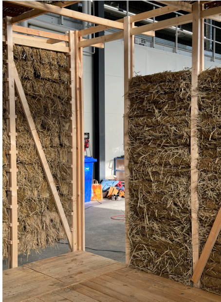
Processus de réalisation des boudins de torchis
