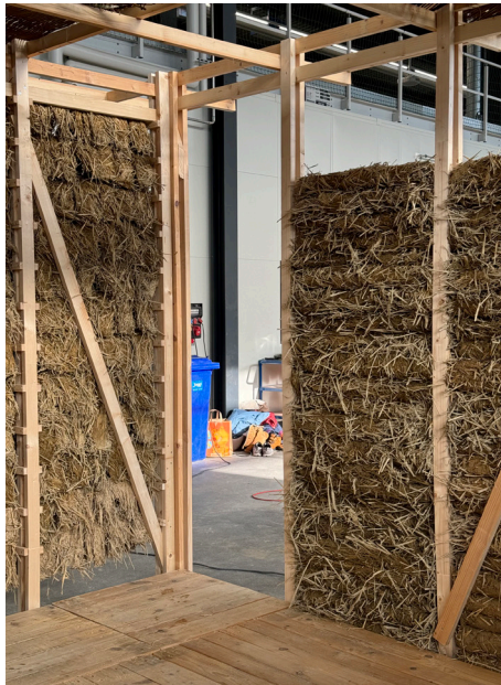
Processus de réalisation des boudins de torchis
