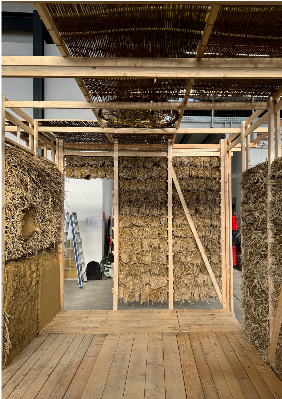
Processus de réalisation des boudins de torchis
