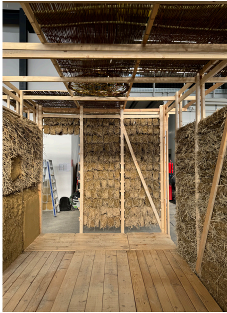
Processus de réalisation des boudins de torchis
