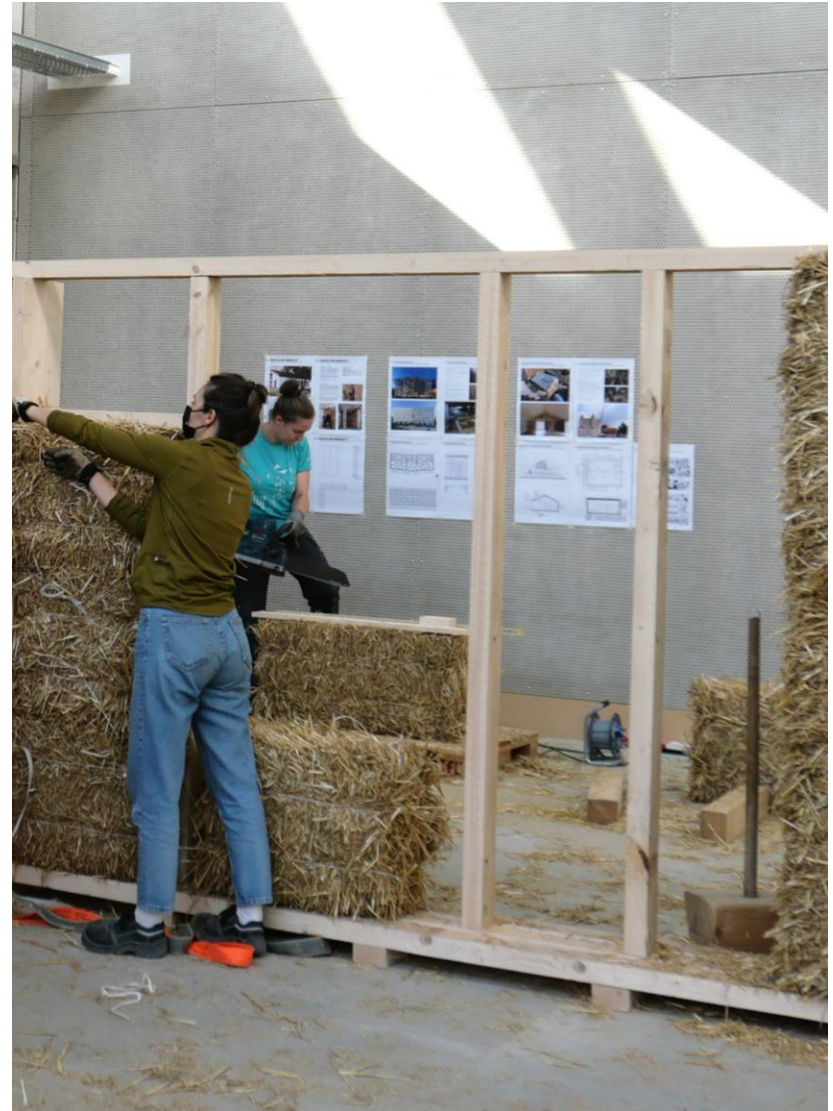
1B – fibres en remplissage wooden structure + straw
