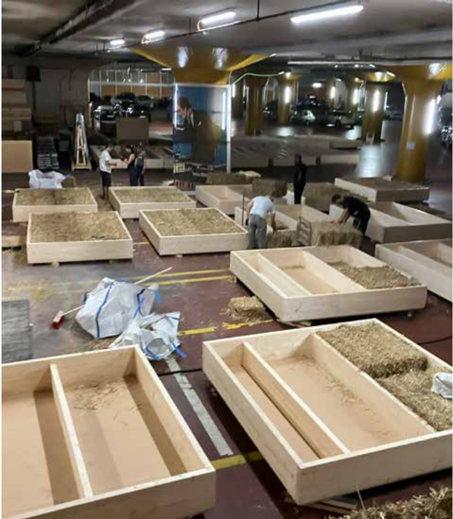
Atelier de préfabrication pour la réalisation du pavillon d'accueil du Château de Grandson, à la Rasude de Lausanne, septembre 2024 (Alentours) Prefabrication workshop for the construction of the visitor pavilion at Château de Grandson, at La Rasude in Lausanne, September 2024 (Alentours)
