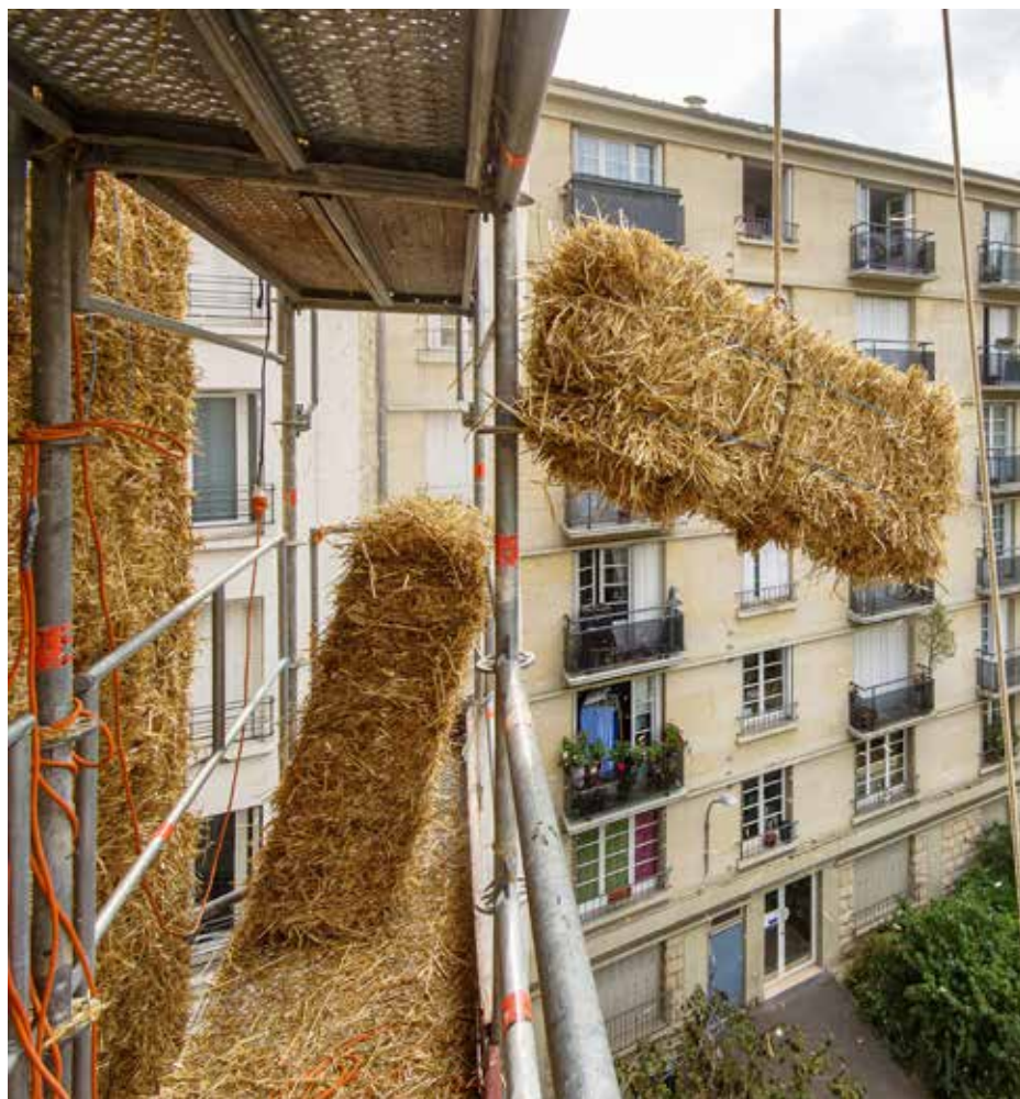
Chantier de l'Isolation thermique par l'extérieur (ITE) paille par bretelles, rue de la Convention, Paris 15e © Raphael Pauschitz / Topophile. Construction site for external thermal insulation (ETE) using straw bale infill, Rue de la Convention, Paris 15th © Raphaël Pauschitz / Topophile.
