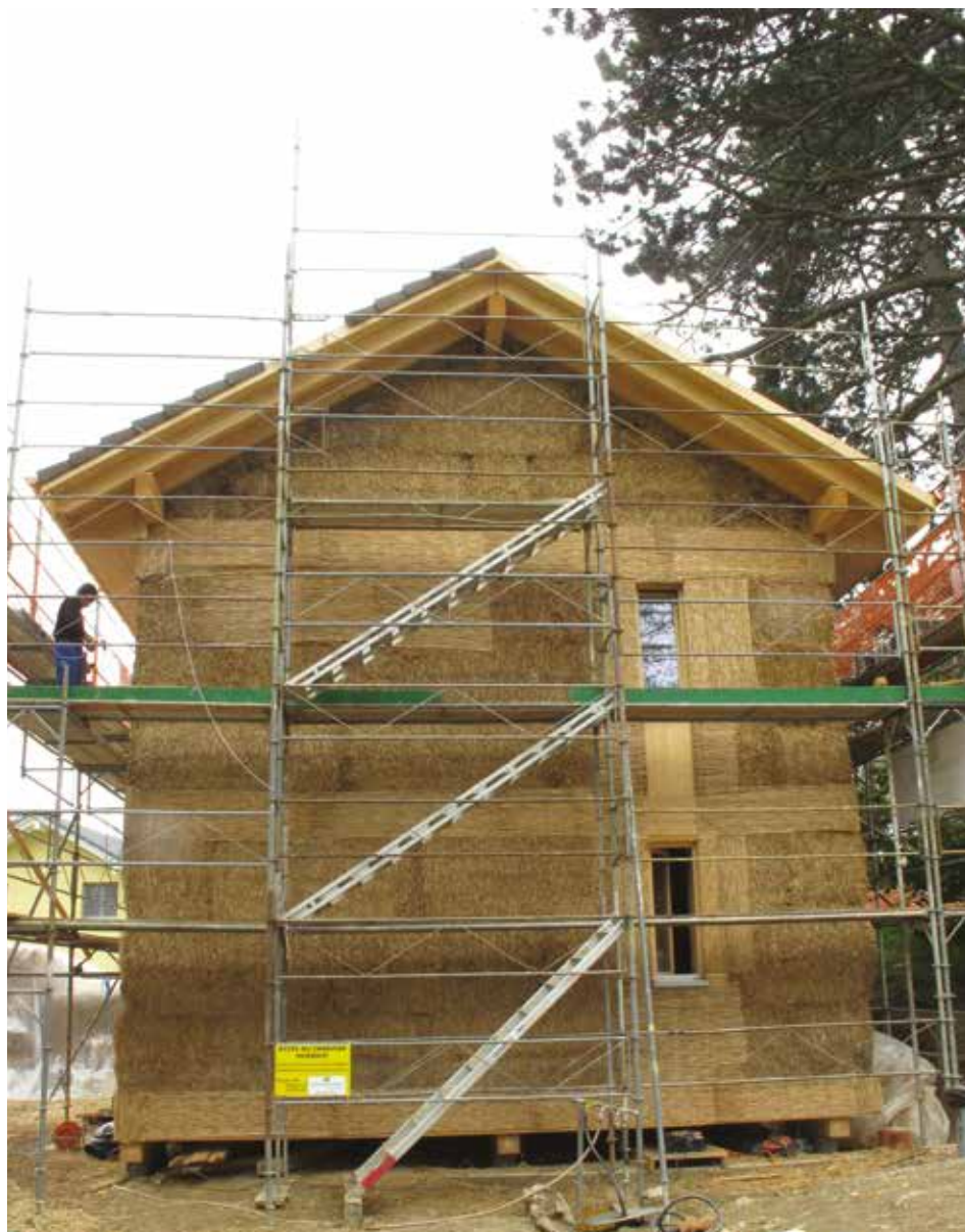
Structure d'une maison en boîtes de paille porteuses sources CArPE. / Structure of a load-bearing straw bale house, Lausanne, Suisse, 2010
