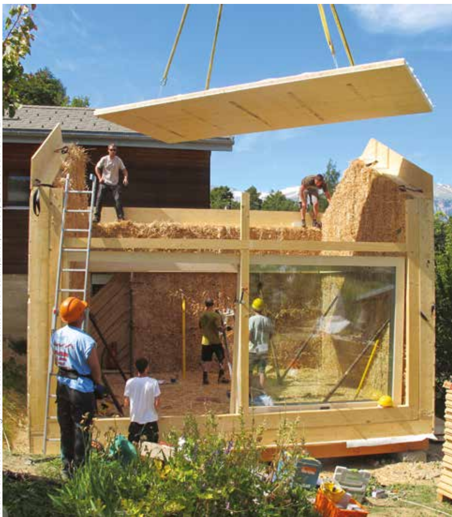
Extension d'une maison en caissons bois impréfabriqués solés en paille, Briex, Suisse, 2016 source CAiPE. House extension using wood caissons isolated with straw, Briex, Suisse, 2016 c'redit CAiPE.
