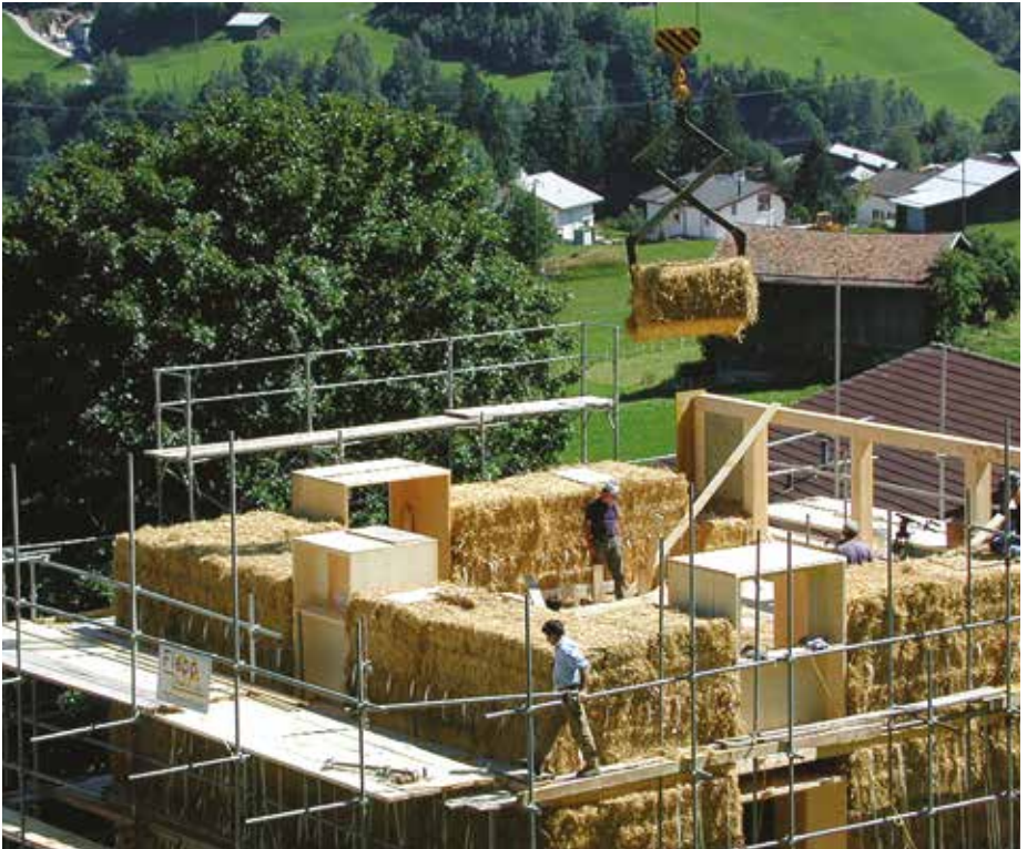
Construction d'une maison en bottes de paille porteuses © Werner Schmidt. Building a house with load-bearing straw bales, Disentis, Suisse © Werner Schmidt.
