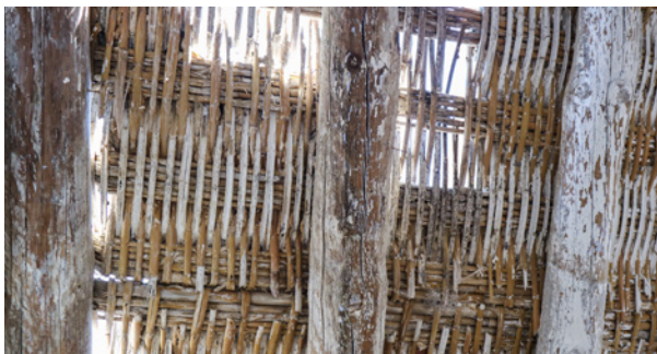
[Fotografía de Rubén Ruberte] (Luceni 2018) Cubierta de cañizo a dos aguas
