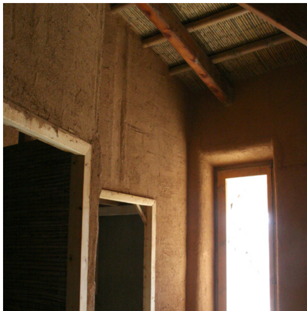
[Fotografía de Oriol Rosselló] (La Pera 2012) Tabique de caña tierra en una casa de nueva construcción.
