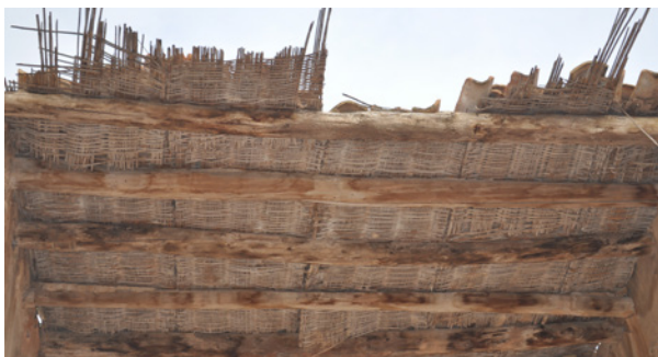
[Fotografía de Voltes - IC] (Belchite Viejo 2017) Techo de cañizo
