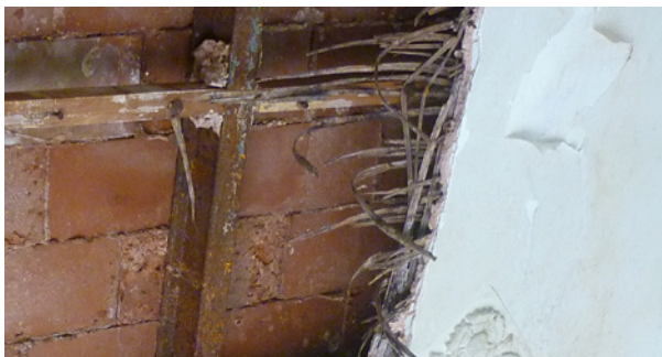
[Fotografía de Voltes - IC] (Barcelona 2017) Cielo raso de cañizo
