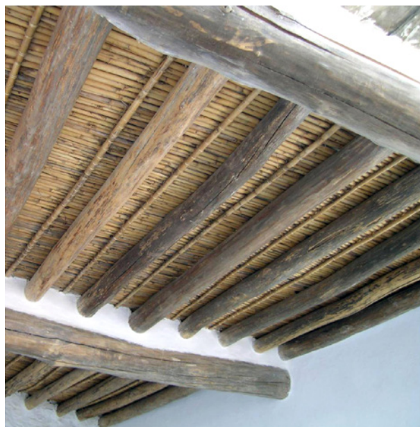
[Fotografía de Jose Manuel López Osorio] (Mairena, Granada 2018) Cubierta de cañizo cosido sobre estructura de madera.
