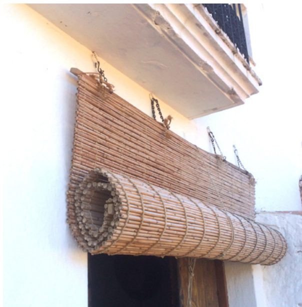
[Fotografía de IC-Voltes] (Xert 2017) Cortina de cañas en Mas de la Creu de Castelló
