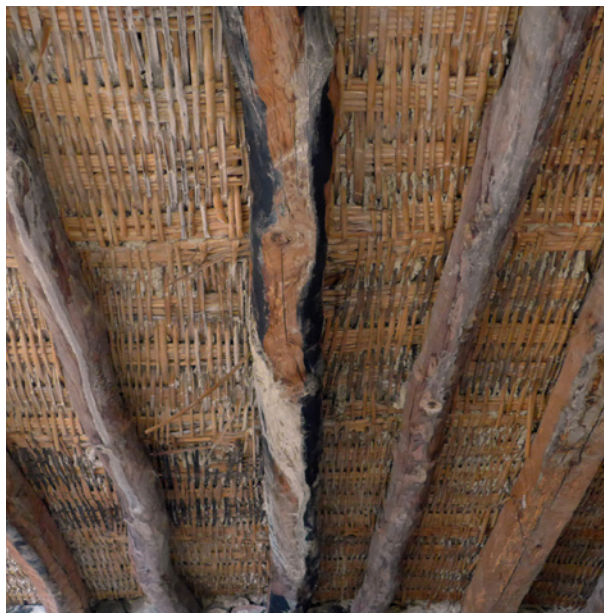
[Fotografía de IC-Voltes] (Huesca 2017) Interior de una cubierta de cañizo en una casa abandonada.
