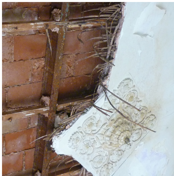
[Fotografía de IC-Voltes] (Barcelona 2017) Falso techo con decoraciones y molduras de yeso.
