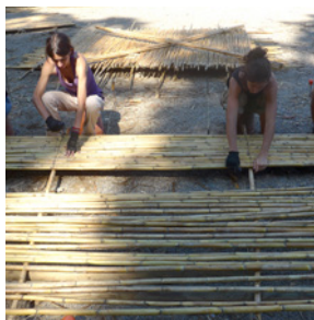
[Fotografía de IC-Voltes] (Girona 2016) Cosiendo un cañizo.
