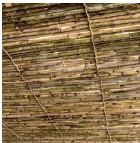
[Fotografía de Econstrucció] (Alfarràs del pi 2015) Cielo raso de cañizo.
