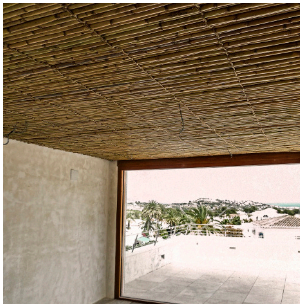
[Fotografía de Econstrucció] (Alfarràs del pi 2015) Cielo raso de cañizo visto para interior.
