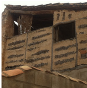
[Fotografía de IC-Voltes] (Aguaviva - Teruel 2018) Cañizo en fachada.
