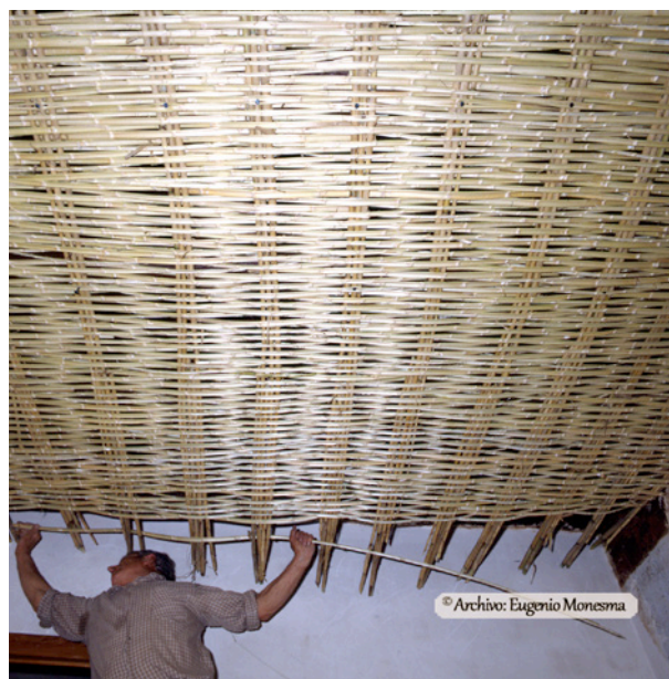
[Fotografía de Eugenio Monesma ] (Huesca) Construcción de un cielo raso documentado por http://www.pyrenepv.com/ .
