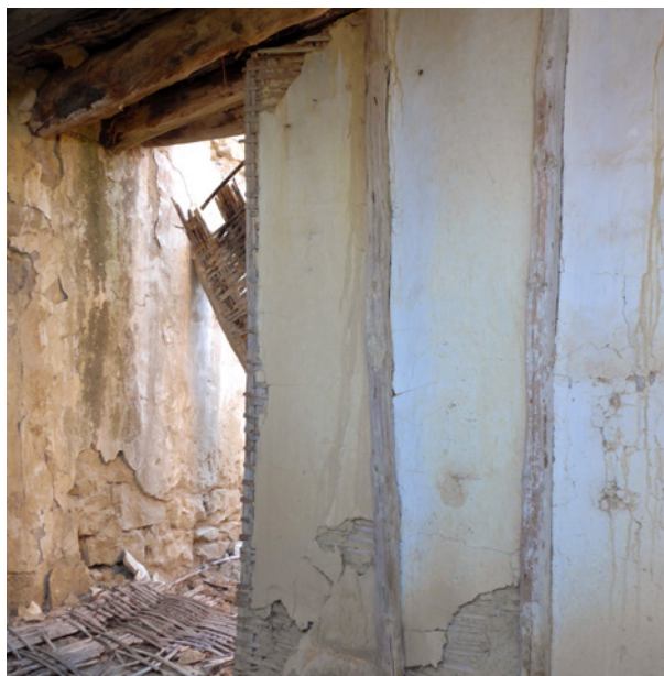
[Fotografía de IC-Voltes] (Huesca 2017) Tabique de caña y yeso en una casa abandonada.
