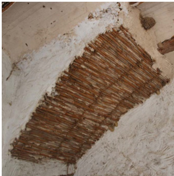
[Fotografía de C.J. Grau y V. La Spina] (Gestaltar, Valencia 2016) Escalera de caña y yeso.
