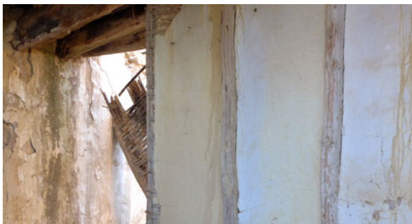
[Fotografía de IC-Voltes] (Huesca 2017) Tabique de caña y yeso
