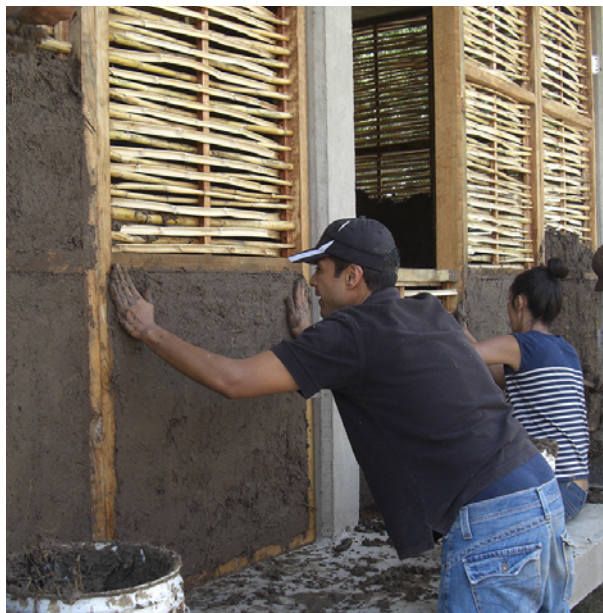
[Fotografía de AKO (Perú 2012) Construyendo una pared de Quincha prefabricada.
