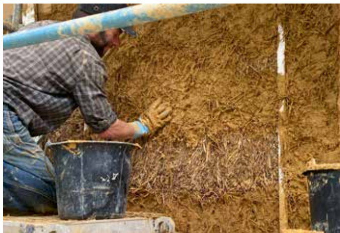
Maison associative urbaine en paille porteuse, 60 m 2 de murs montés et enduits en six semaines de chantier participatif – Nebraska pour Projet EPI, Villeurbanne, France (ASSOCIATION NEBRASKA)
