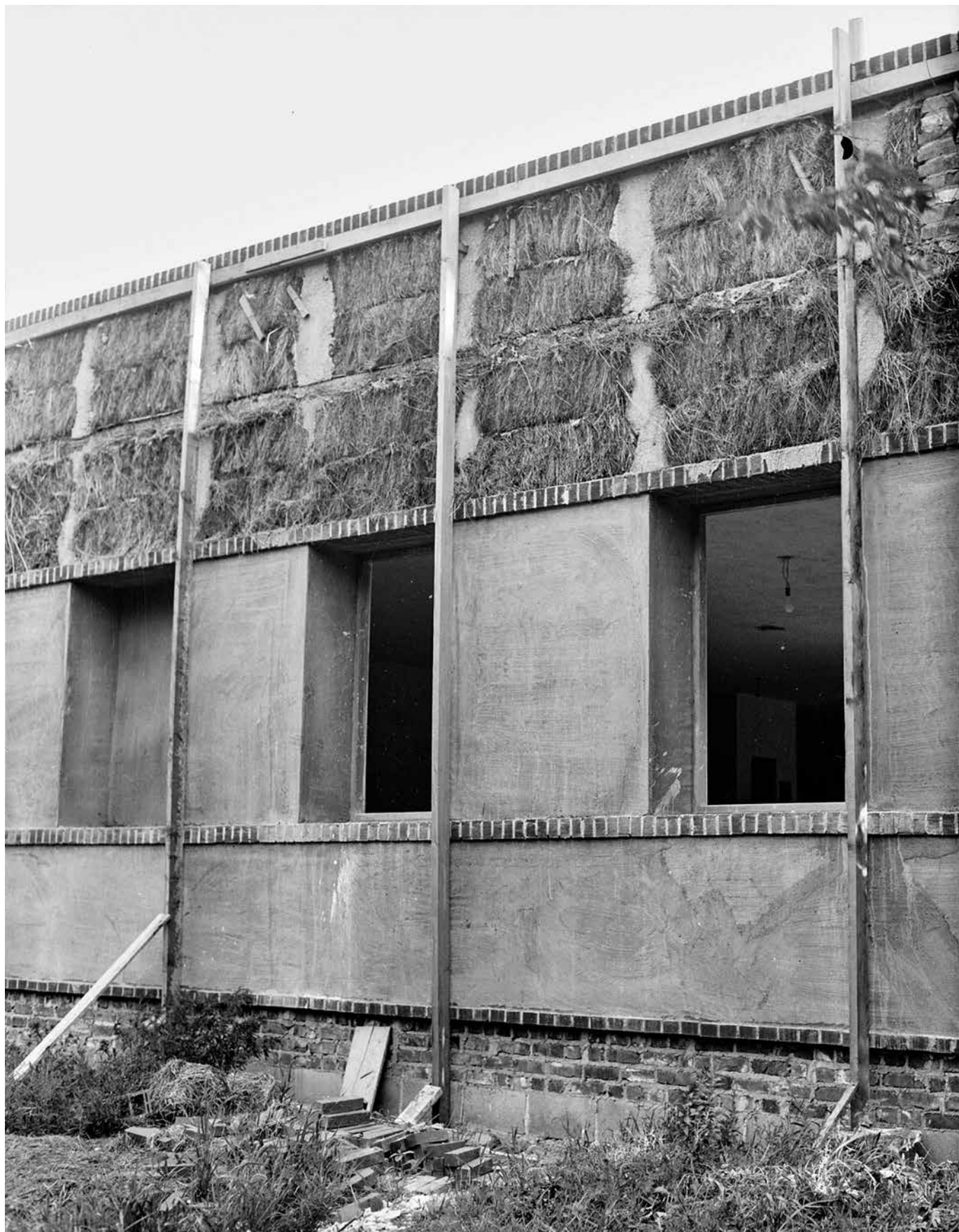
Bottes montées dans le mur du Lone Oak, à quelques miles à l'ouest de Lincoln, Nebraska (voir p. 27), à l'aide d'un généreux mortier de ciment (NSHS RG2183.1945.0730.3 – TOPOPHILE)
