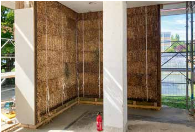
Mur réalisé avec la technique Nebraska : après compression des petites bottes, les sangles seront noyées dans les crépis intérieurs et extérieurs (ALIA BENGANA)
