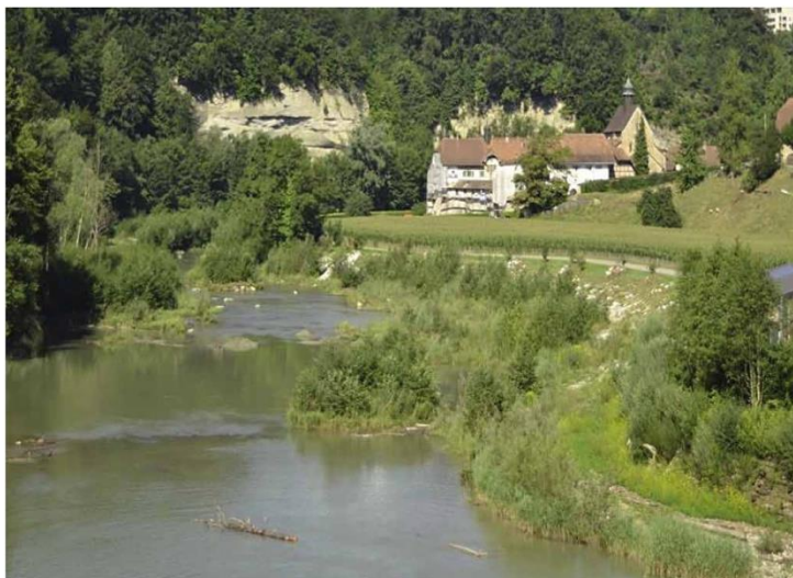
Résultat après les travaux © SEn
