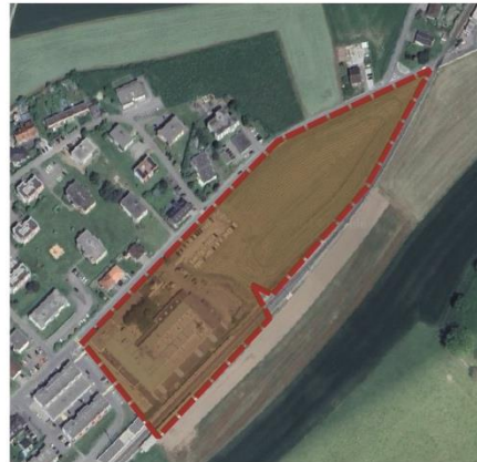
Zone de centre Belfaux
