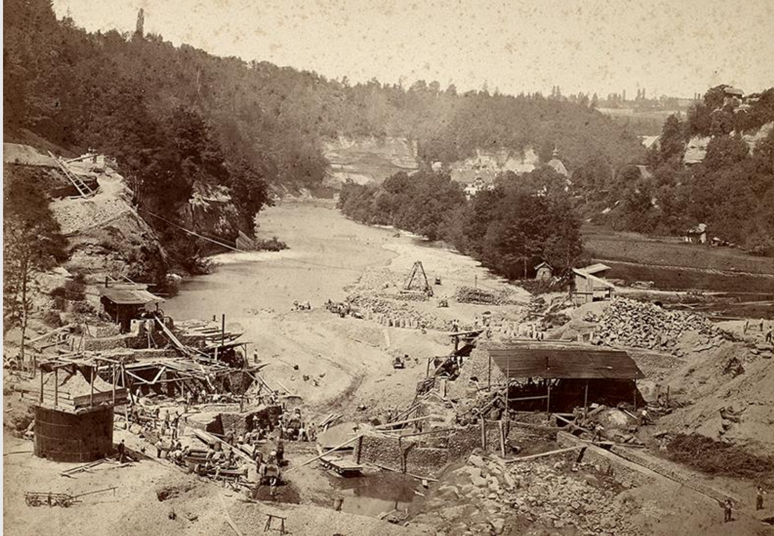
Construction du barrage de la Maigrage (1872)
