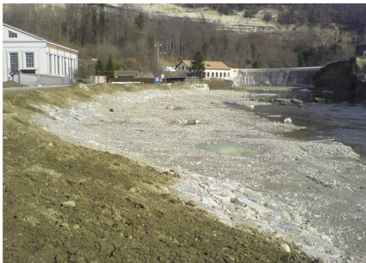
Travaux d'aménagement pour redonner de l'espace à la Sarine suite aux dégâts causés par la crue © SEn
