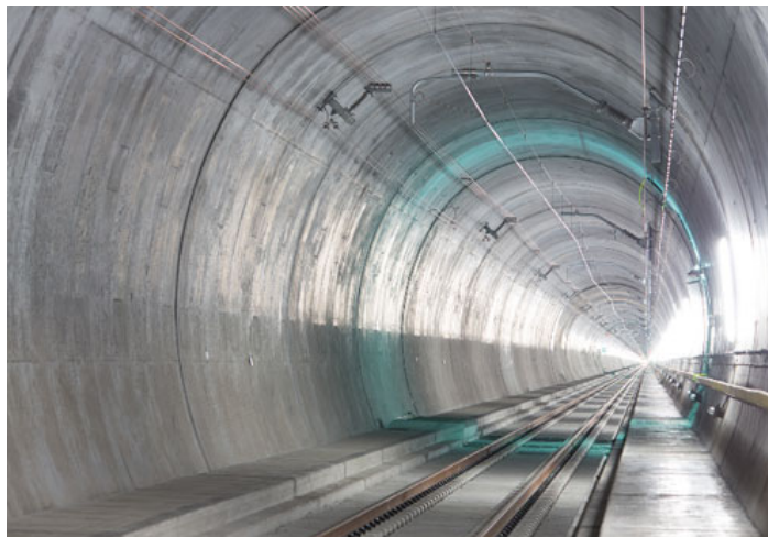
Voûte de tunnel
