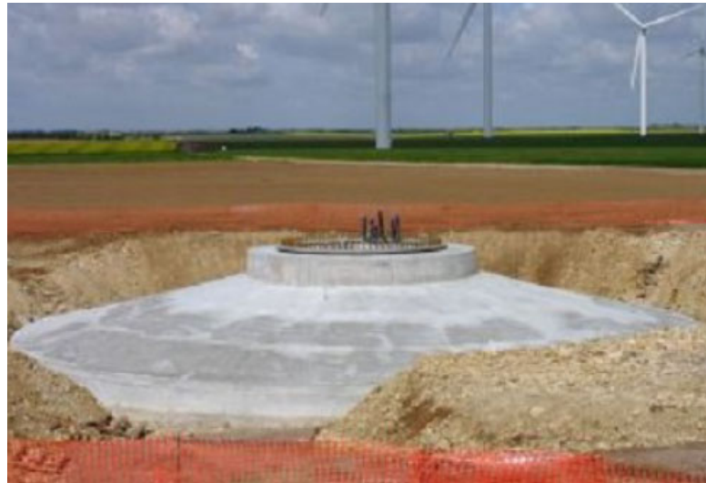
Massif de fondation pour éolienne
