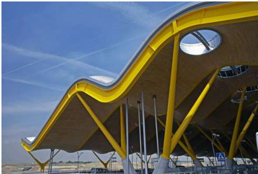
Aéroport de Barajas, Rogers, Madrid, 2005
