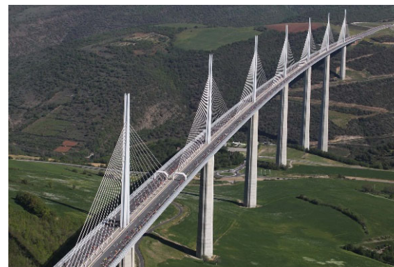
Viaduc de Millau, 2004
