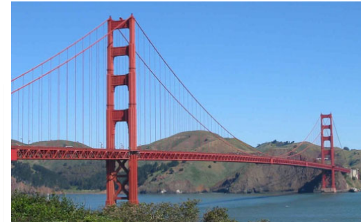
Pont du Golden Gate, San Francisco, 1917
