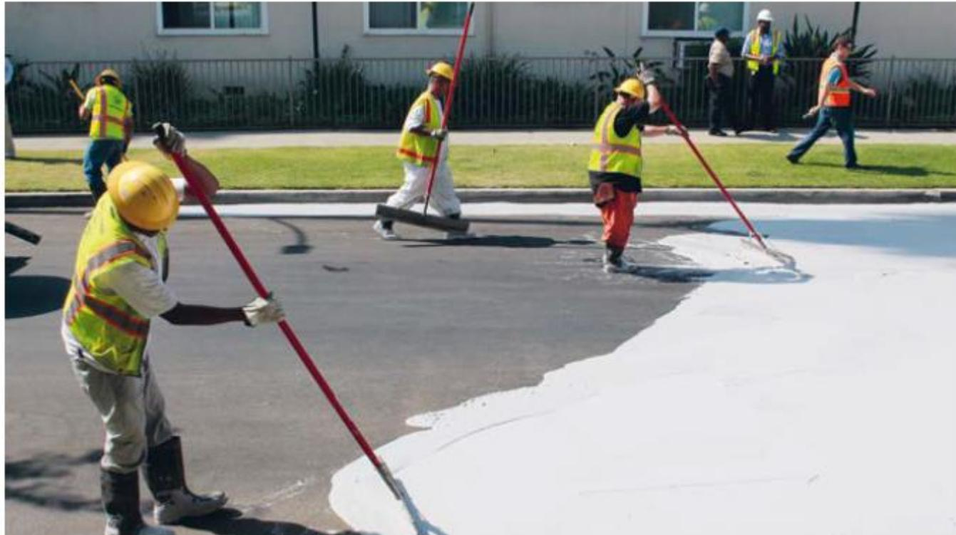
Repeindre une rue avec un enduit réfléchissant permet de réduire la chaleur qu'elle restitue – Le projet pilote « Cool Pavement » à Los Angeles [Source: OFEV, 2018, Quand la ville surchauffe](#)
