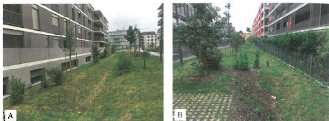
14.13 Noues conçues pour la rétention et le transport des eaux de surface dans le nouvel éco-quartier des Vergers à Meyrin GE.
