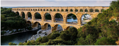
III. 155 : juxtapositions et superpositions de structures en arc : concept de coupe visant à éviter d'utiliser tout matériau superflu. La construction en arc est ici motivée par des arguments techniques et économiques. Le pont du Gard, aqueduc romain près de Nîmes (F) 1 er s. apr. J.-C.
