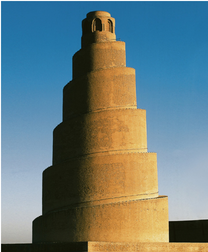
Minaret hélicoïdal de la Grande Mosquée de Samarra, Irak , 848-852. ( www.fr.wikipedia.org ) A l'origine recouverte de mosaïques vert-bleu foncé. Rampe hélicoïdale qui conduit au sommet, à une hauteur qui culmine à 52m. (Réf. 21, p. 87)
